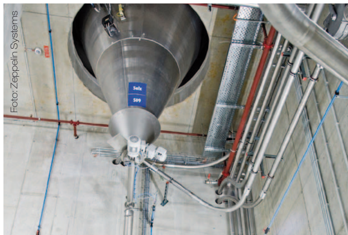
Bild links: Die Außensilos sind auf dem Dach des Rohstofflagers installiert, was besondere statische Anforderungen nach sich zog. Bild Mitte: Die einzelnen Silos der Hauptkomponenten beanspruchen somit keinen Platz im Gebäude. Bild rechts: Die Zutaten werden zunächst verwogen und dann in den Schraubenbandmischer gefördert.
