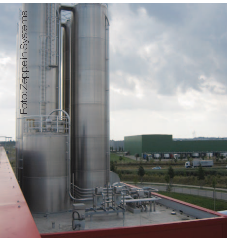
Bild links: Die Außensilos sind auf dem Dach des Rohstofflagers installiert, was besondere statische Anforderungen nach sich zog. Bild Mitte: Die einzelnen Silos der Hauptkomponenten beanspruchen somit keinen Platz im Gebäude. Bild rechts: Die Zutaten werden zunächst verwogen und dann in den Schraubenbandmischer gefördert.
