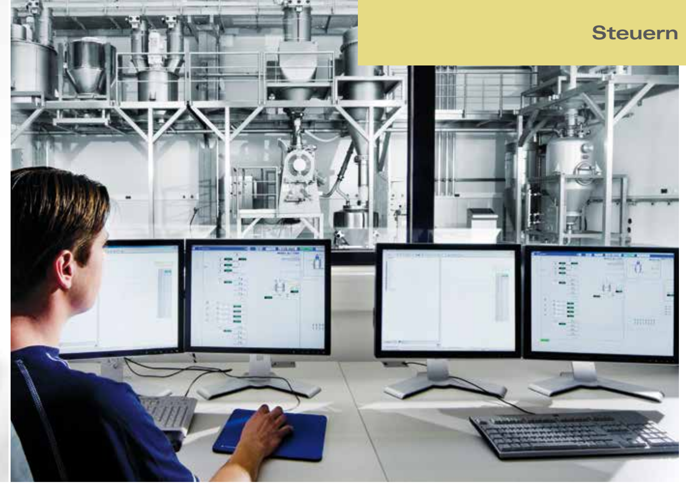
Steuerung der Anlagenprozesse
